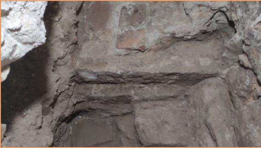
Foto 15. Vista de detall de la riosta UE 16.
