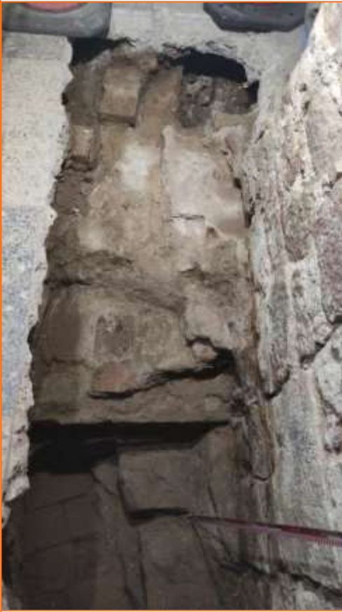
Foto 17. Vista general del paviment UE 19, de la riosta UE16 i del basament del pilar UE 12.
