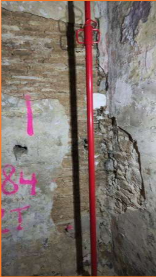
Foto 55. Vista de la Cala parietal 20.
