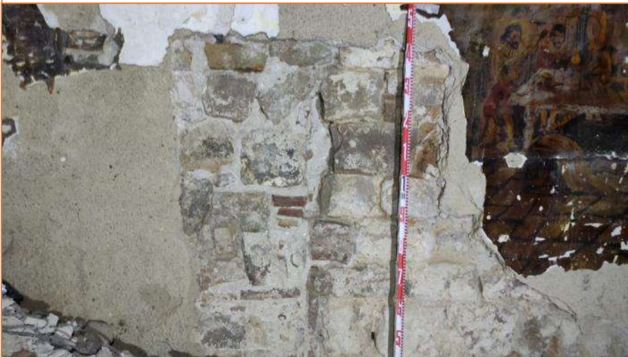
Foto 34. Vista de la Cala parietal 1.
