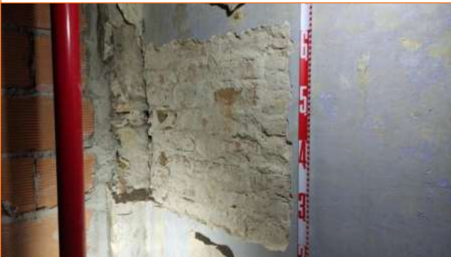
Foto 46. Vista de la Cala parietal 12.
