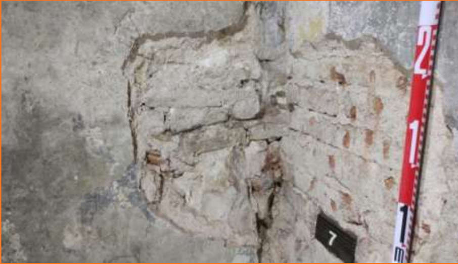
Foto 41. Vista de la Cala parietal 7.
