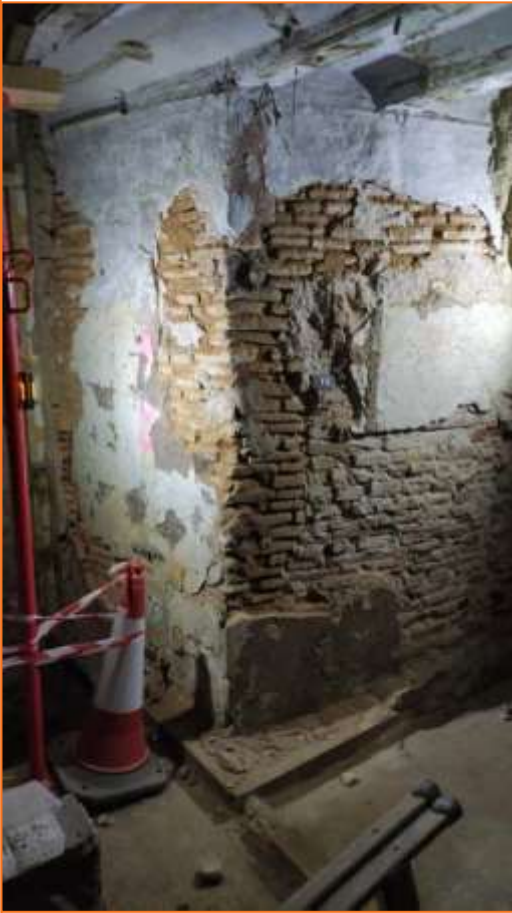
Foto 47. Vista de la Cala parietal 13.
