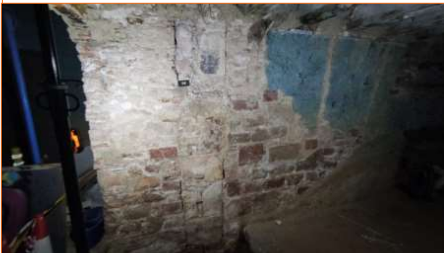
Foto 48. Vista de la Cala parietal 14.
