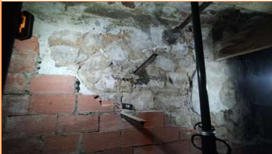
Foto 50. Vista de la Cala parietal 16.
