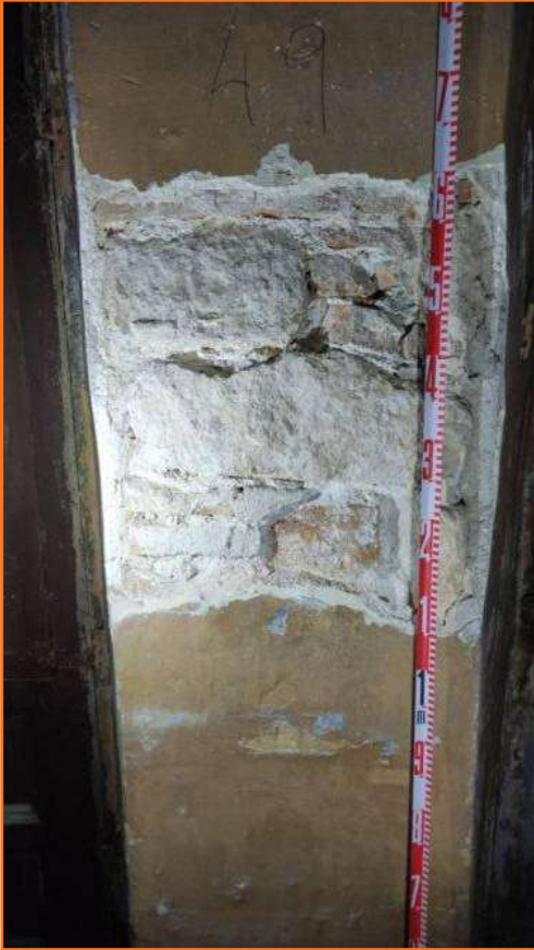
Foto 45. Vista de la Cala parietal 11.
