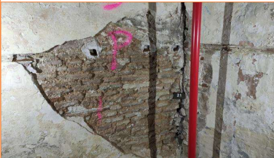
Foto 56. Vista de la Cala parietal 21.
