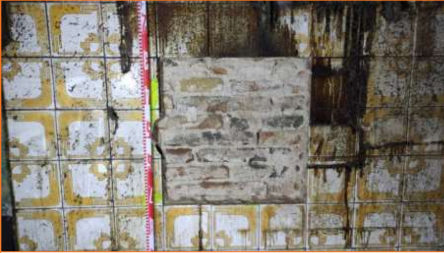
Foto 35. Vista de la Cala parietal 2.
