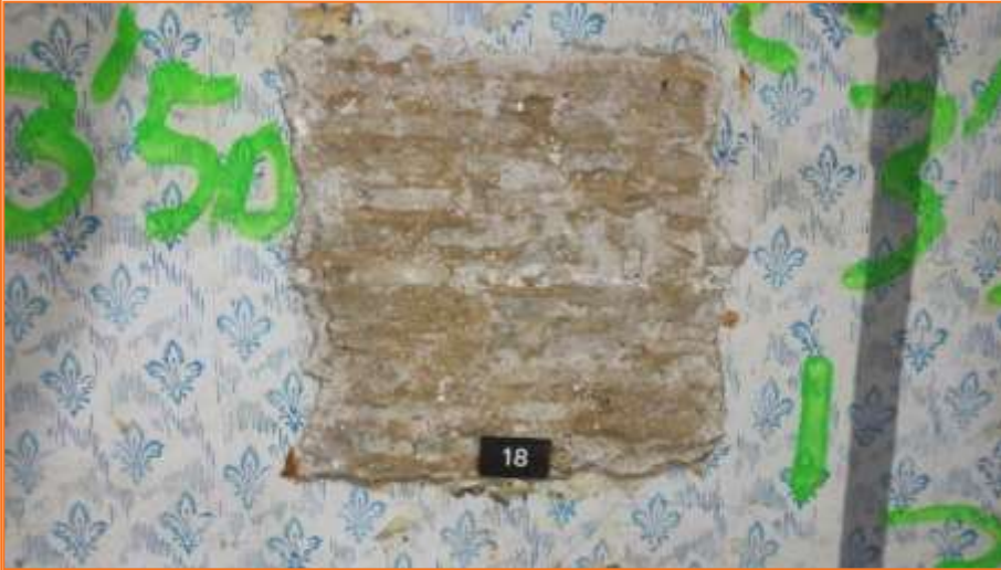
Foto 53. Vista de la Cala parietal 18.
