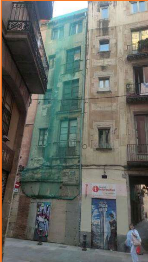
Foto 1. Vista de la façana de l'edifici a la plaça de la Llana.
