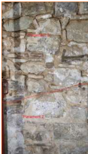
Fig. 4. Vista dels Parament 2 i 3
