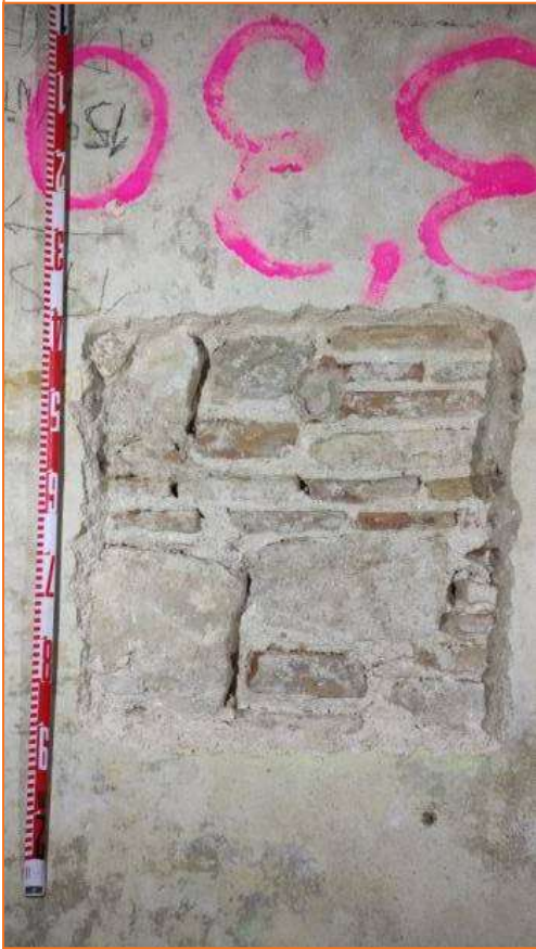
Foto 43. Vista de la Cala parietal 9.
