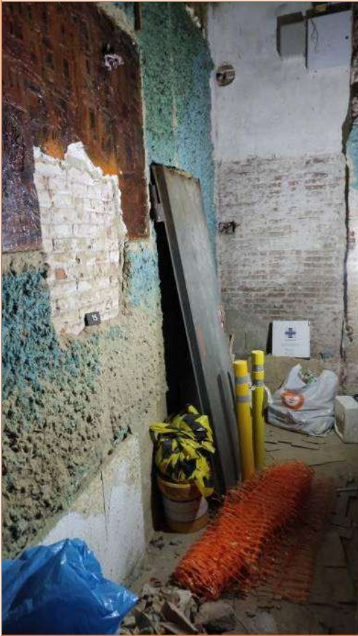
Foto 49. Vista de la Cala parietal 15.
