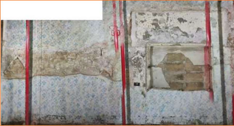
Foto 51. Vista de la Cala parietal 17.
