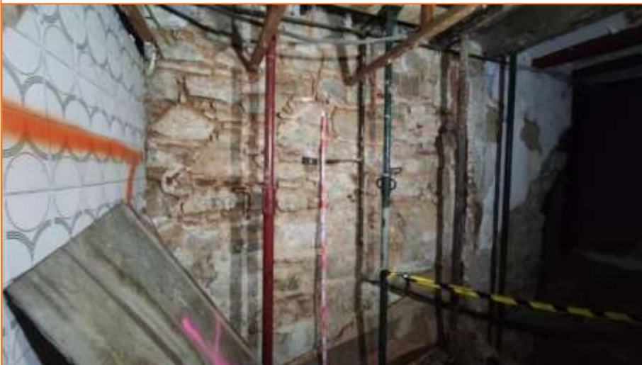
Foto 36. Vista de la Cala parietal 3.
